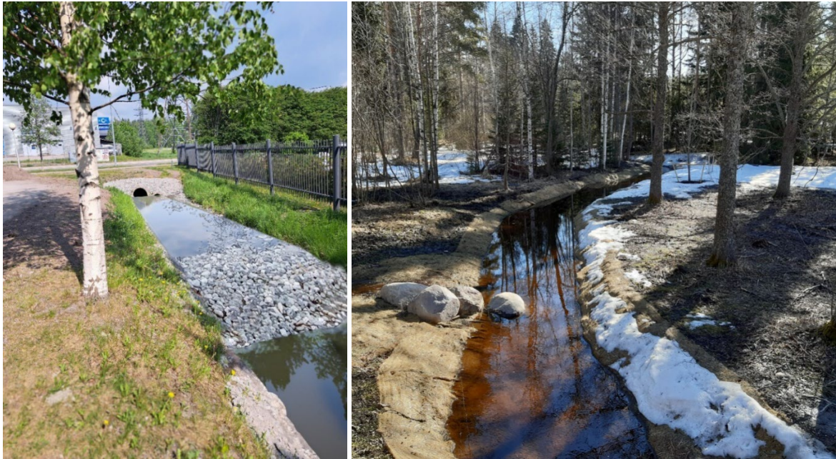
Kuva 13. Vasemmalla havainnollistus ojan yhteyteen toteutetusta väliaikaisesta suotopadosta kiintoaineiden poistamiseksi työmaavesistä. Oikealla eroosiosuojakankaalla suojattu oja. © Destia Oy 2024.
