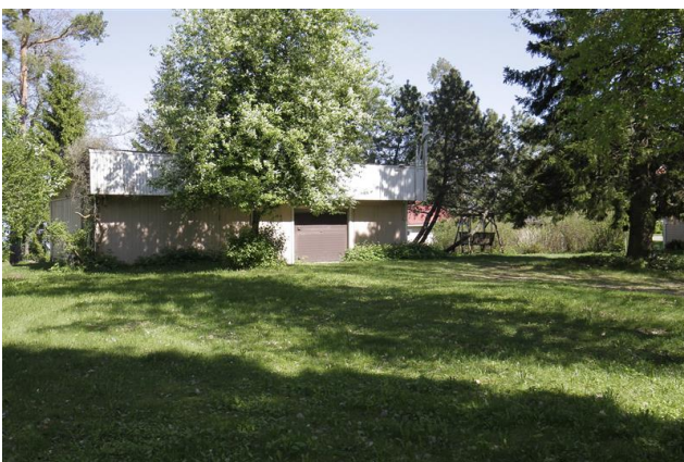
Kuvateksti: Autotalli osoitteessa Ranniituntie 77 kuvattuna lounaasta. Pulpettikattoinen rakennus on luultavasti 1960-luvulta. Kuvalagi: yksityiskohtakuva Kuvaaja: Minttu Kervinen Kuvausaika: 22.5.2024
