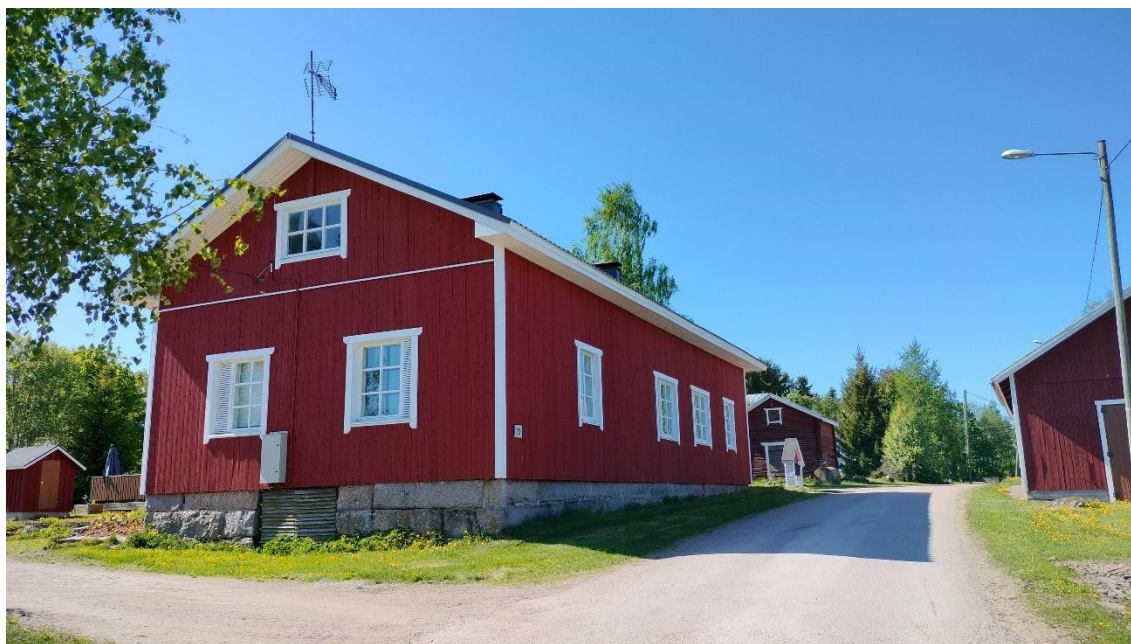
Kuva 45 Huntun päärakennus kaakosta. Rakennuksen julkisivusta puuttuu vielä saneeraustyön jäljiltä peiterimoitus.
