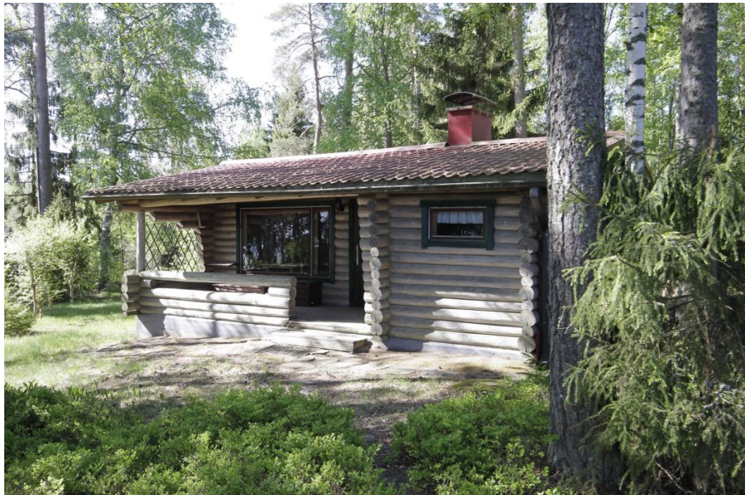
Kuva 51 Koruniemessä sijaitseva 1970-luvun kesämökki on rakennusajalleen tyyppinen pyöröhirsinen, avokuistillinen kesämökki.
