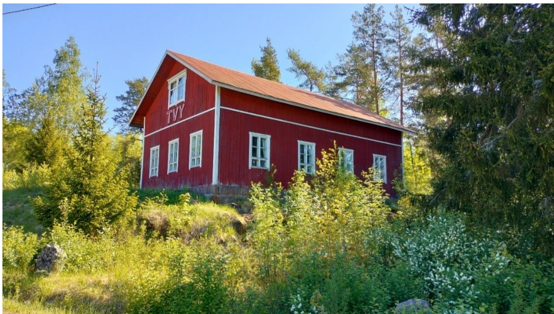
Kuva 35 Mannilan työväenyhdistyksen talo on rakennettu 1900-luvun alussa.
