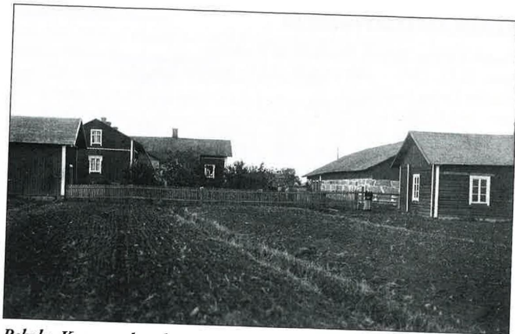
Rekola. Kuvassa oleva kivinavetta on säilynyt, muut ovat purettu uusien tieltä.
