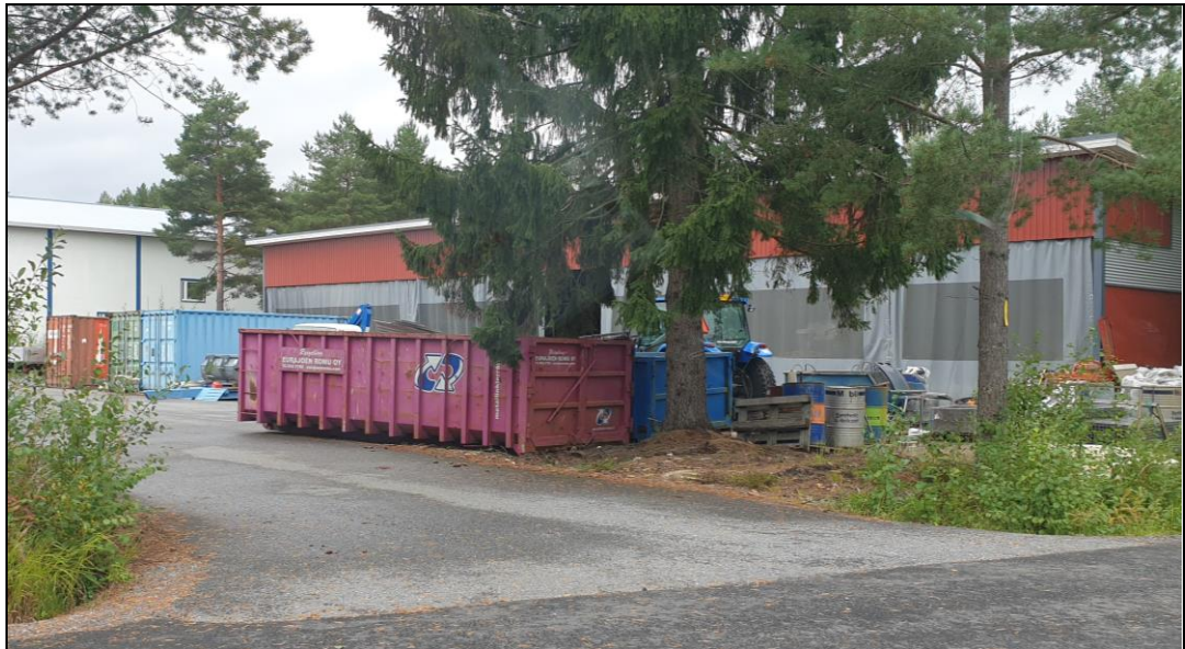
Kuva 17. Yritystonteilla pientä pohjavesiriskiä aiheuttaa romujen ja haitta-aineiden varastointia. Asfaltoiduilla alueilla haitta-aineiden pääsy suomaan maaperään on estetty.
