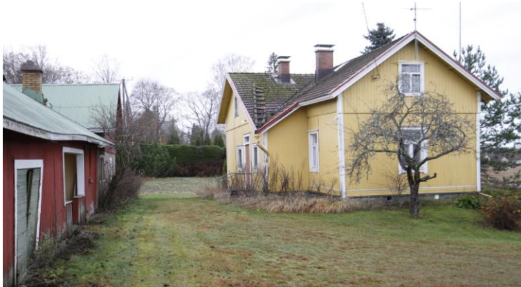
Kuva 6. Mäkilän asuinrakennus ja talousrakennus. Kuvassa oikealla näkyvän asuinrakennuksen vanhimmat osat ovat 1880-luvulta, mutta rakennusta on laajennettu useaan kertaan ja se on pystyvuorattu 1900-luvulla. Nykyisin rakennus on keltaiseksi maalattu ja vesikatteena on sementtitiilet. Ikkunat ovat vanhan mallin mukaan uusittuja T-ikkunoita. Kuvan vasemmassa reunassa näkyy 1900-luvun alun talousrakennus, jonka osana on sementtitiilinen entinen navetta.
