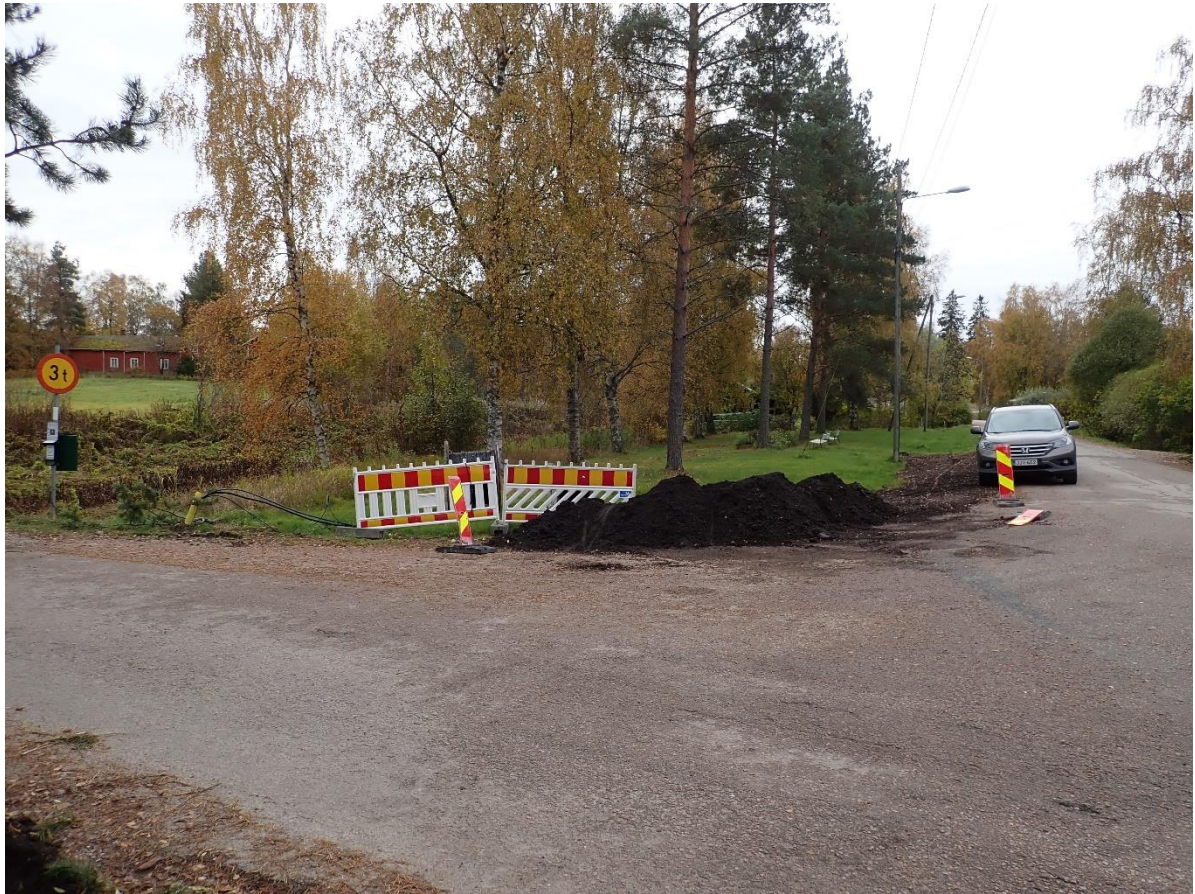
Muinaisjäännöksen alueella oli tehty hiljattain kaapelointitöitä. Kuvattu kohti lounasta.
