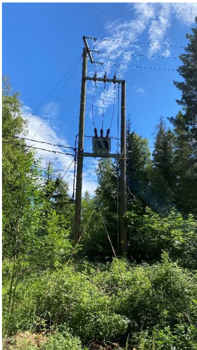
Suunnittelualueella sijaitseva sähkölinja.
